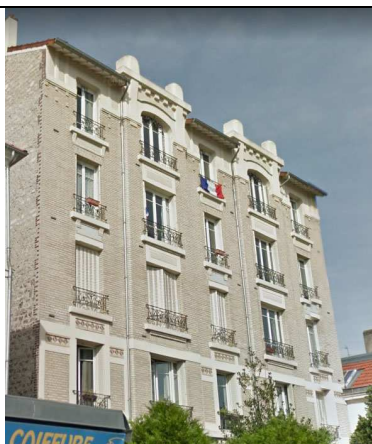
Immeuble en pierre et en brique "venue de la Division eclerc
