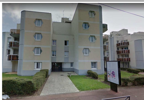
Immeuble collectif - Grand ensemble Rue Gallieni
