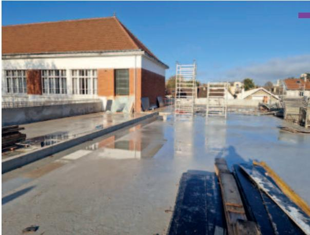
Coulage de la dalle de plancher haut du futur accueil de loisirs de l'école Poincaré (rez-de-chaussée aile droite) et montage des murs préfabriqués pour l'espace qui accueillera trois nouvelles salles de classe et deux ateliers (2<sup>e</sup> étage aile droite)
