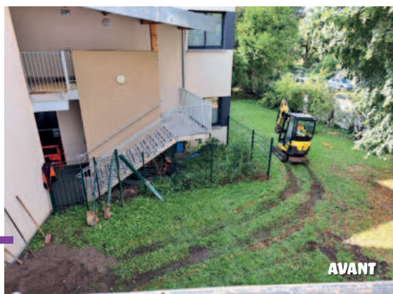
ÉCOLE SAINTE-MARIE Mise en conformité : Création d'un cheminement piéton permettant l'amélioration des conditions de sécurité (22 500€ TTC)
