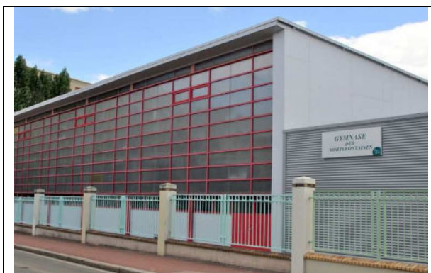
Gymnase des Mortefontaines Rue Eugène Lamarre
