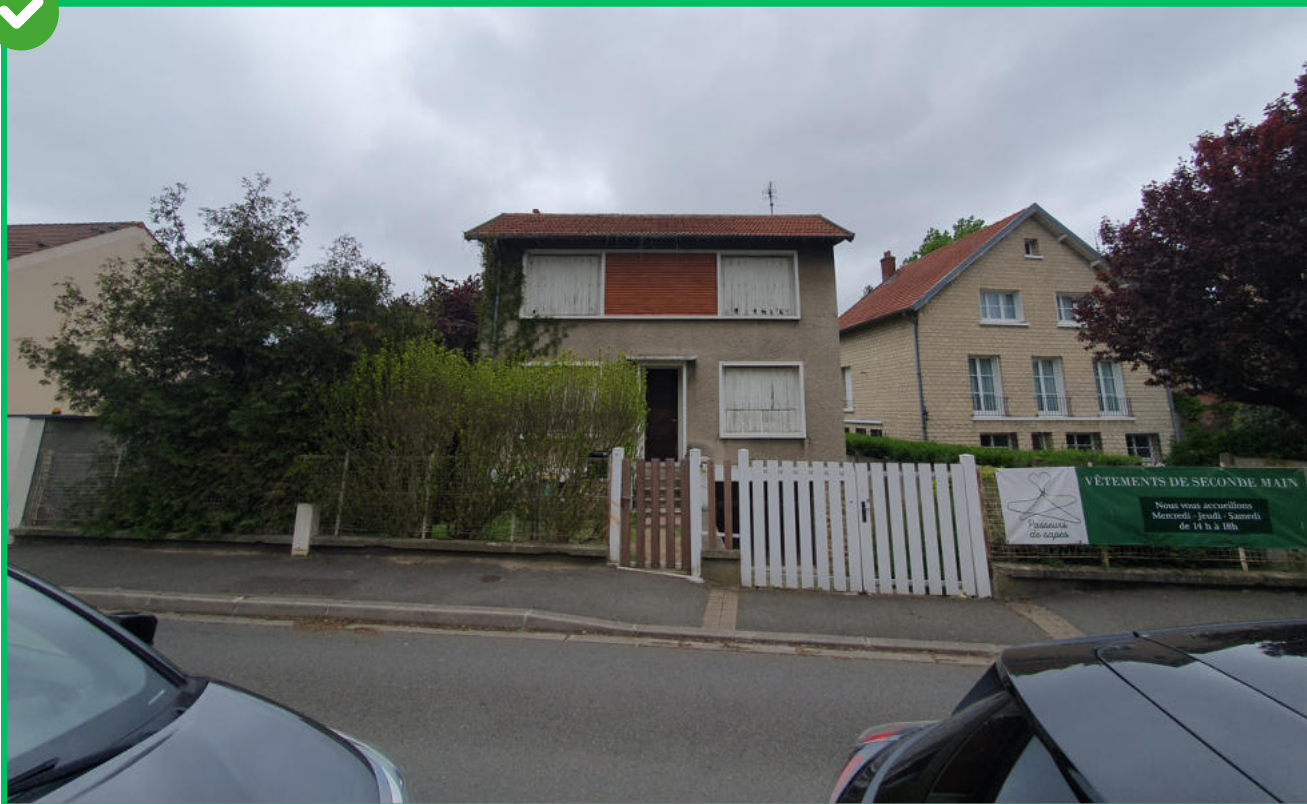
Façade sur rue / Existant
