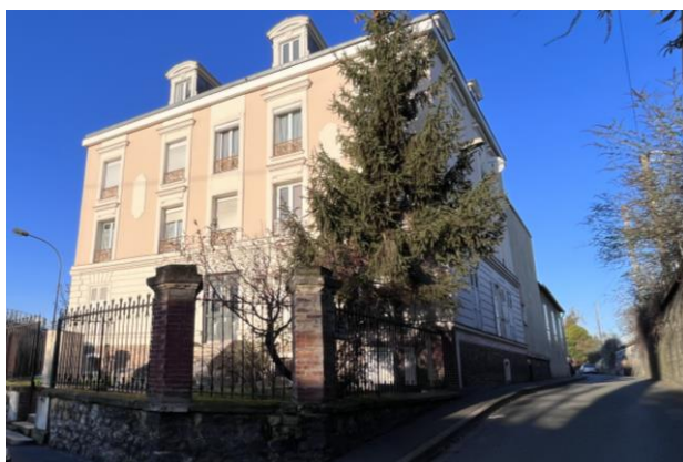
145 rue du chemin de fer
