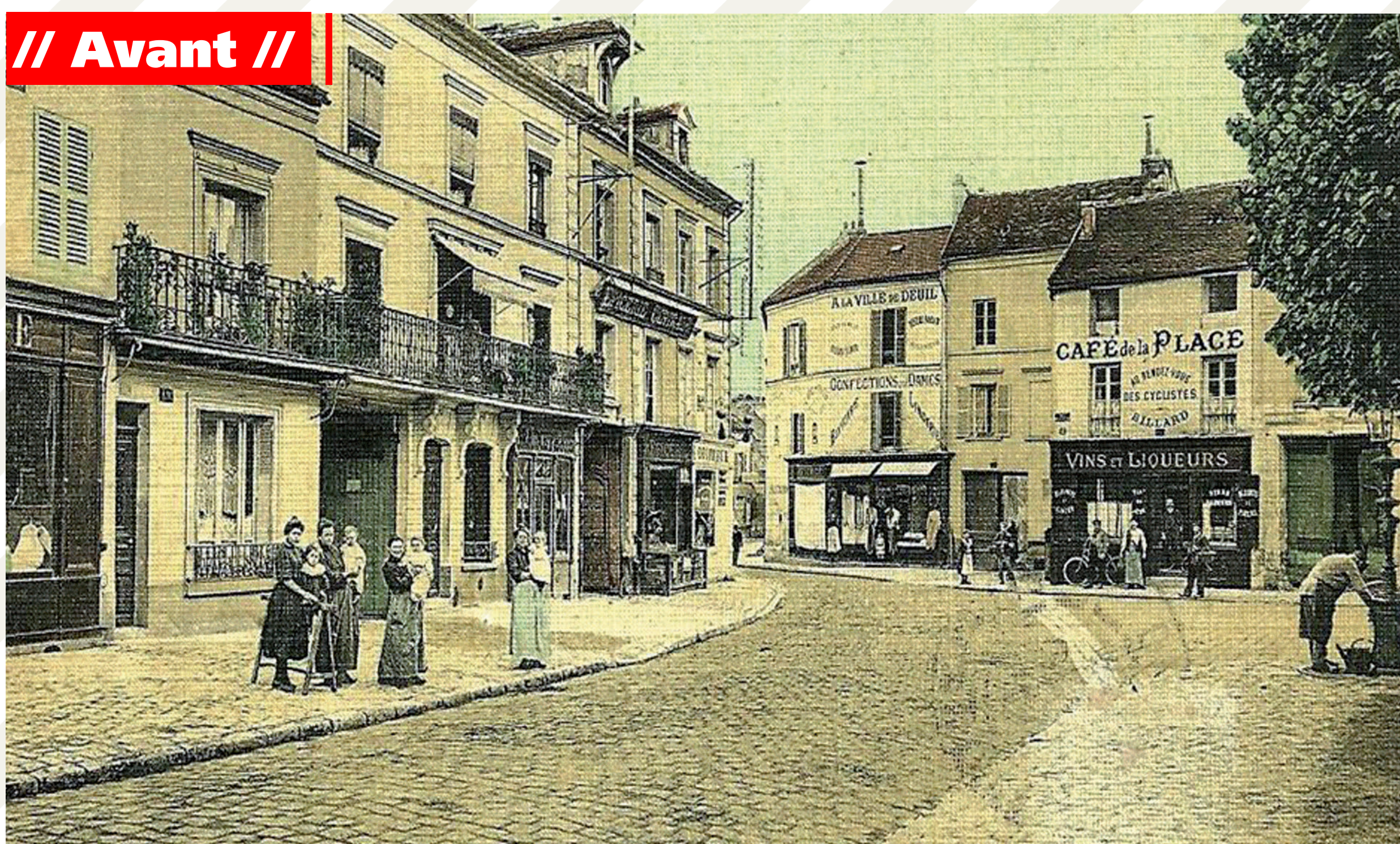
Quartier de l'église avant 1944.
