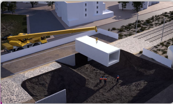
Image projetée de l'opération de construction du passage souterrain.
